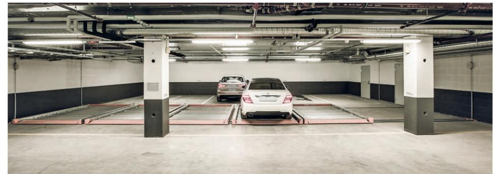
**Палетные системы** могут быть интегрированы в существующие гаражи или автостоянки. Парковочные платформы, движущиеся по рельсам перемещаются в продольном (PE-PH) и поперечном направлении (PQ) с помощью электродвигателя, таким образом предоставляя независимый доступ ко всем парковочным местам.
